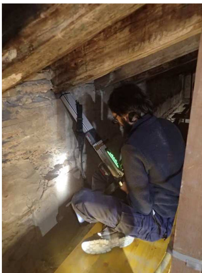
Análisis del estado interno de una vigueta de madera antigua mediante la técnica no destructiva de resistografía.
